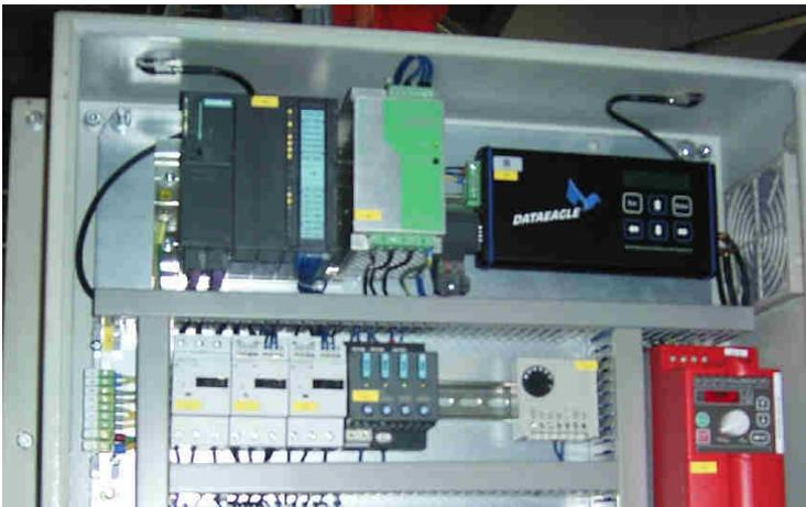
**Richtig:** Antennen oberhalb des Schaltschranks montieren
