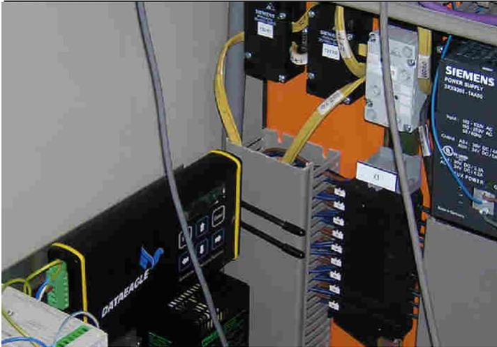
**Falsch:** Keine internen Antennen im Schaltschrank montieren!
