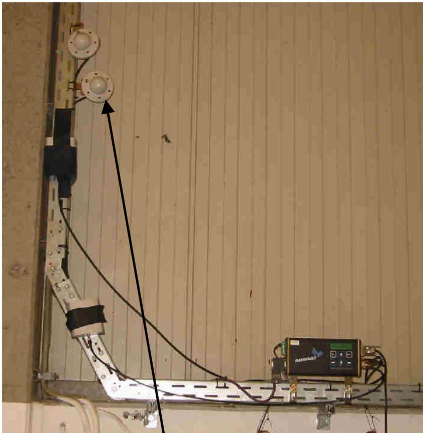
**Falsch:** 90° verdreht montierte Antennen 10361
